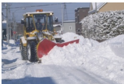
除雪ドーザー
