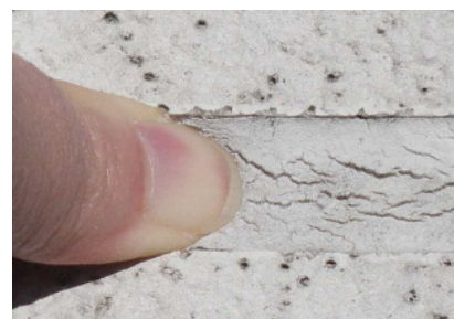
●指圧による亀裂の深さの確認
