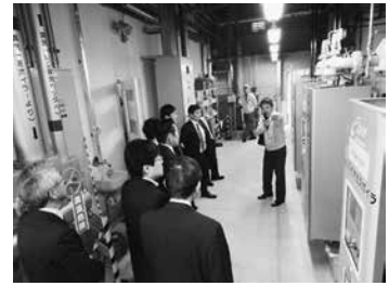
【下水道バイオマスエネルギー利活用施設の現地視察】
