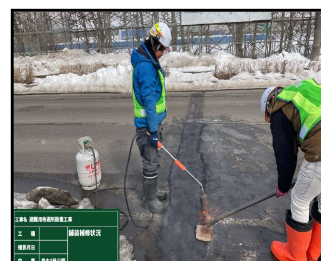
③桜木 3 号公園付近での クラック補修の様子
