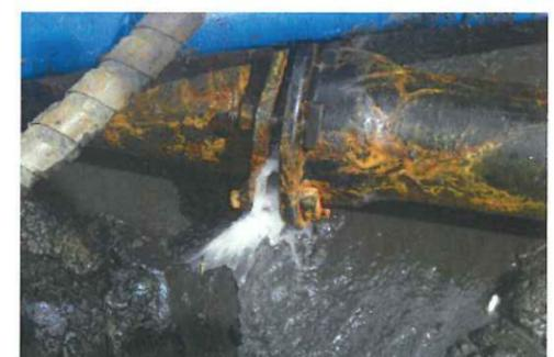
老朽化した水道管からの漏水
