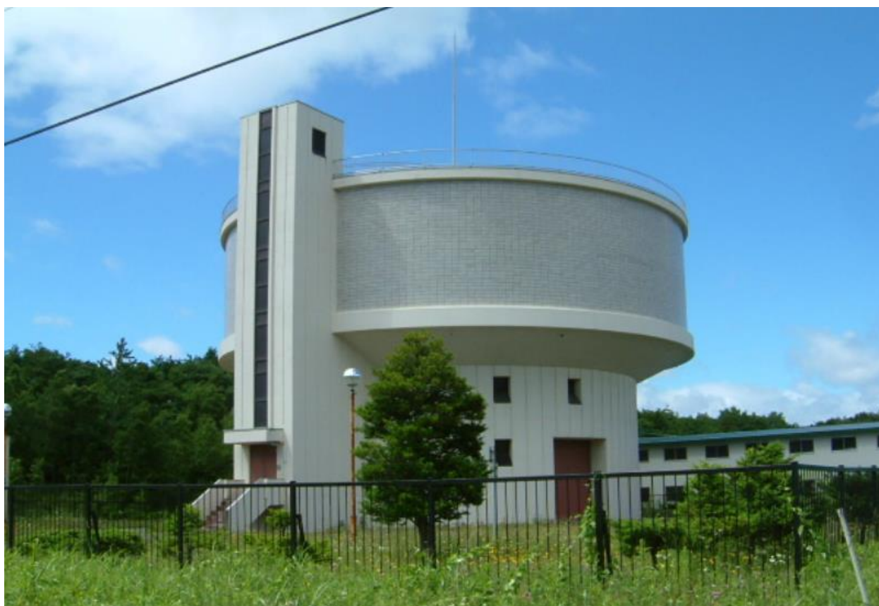
上長都高架配水池
