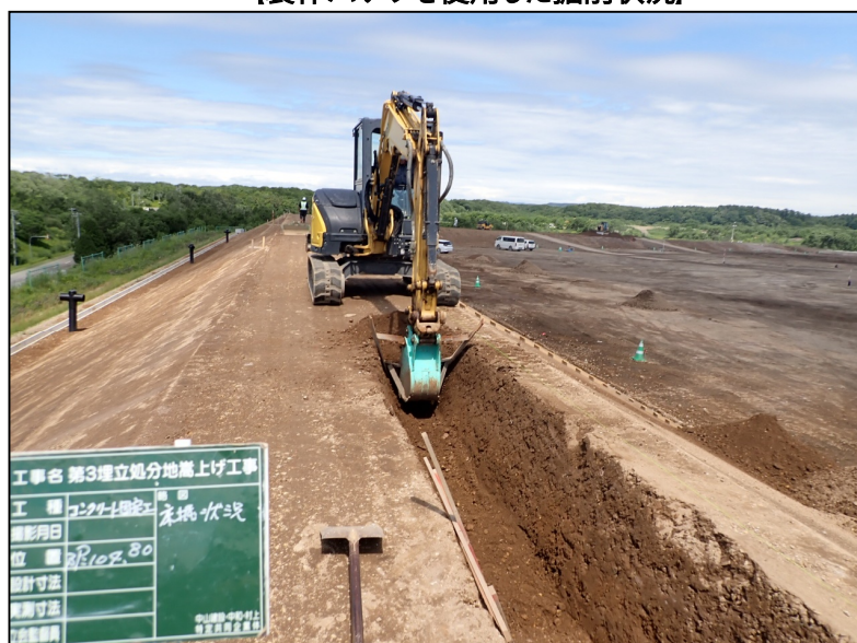
【製作バケツを使用した掘削状況】
