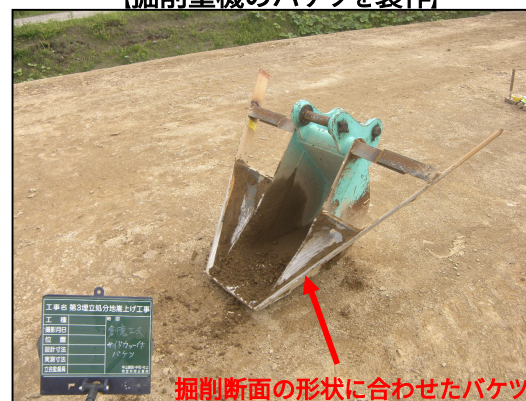
【掘削重機のバケツを製作】
