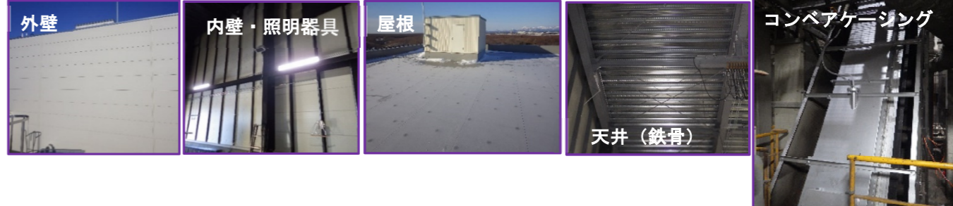
【火災1】復旧状況
