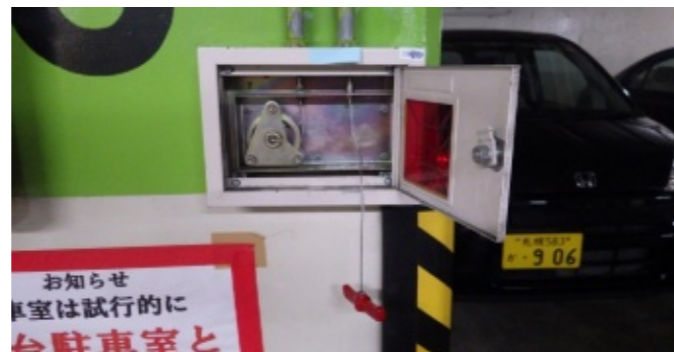
手動ワイヤー動作不良修繕
