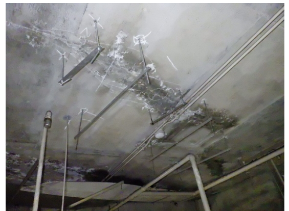
写真2.1 地下2階天井面の貫通ひび割れ（漏水あり）
