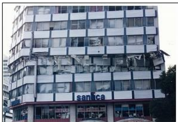
鉄骨鉄筋コンクリート造9階建ての5階部分が完全に層崩壊し、6階以上の階が傾いた商業ビル (阪神・淡路大震災) 写真：日本技術開発(株)提供
