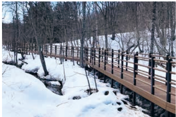
写真29 園路「高架木道」の事例(4) (西岡水源地：鋼材+再生木材)
