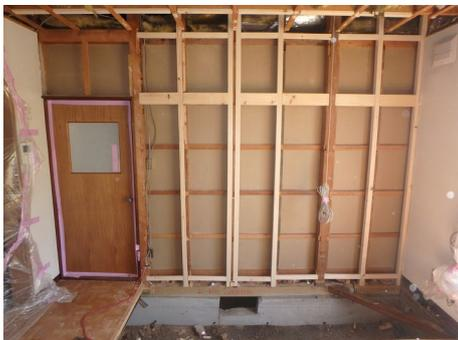
・構造用合板の設置（耐力壁の設置2）
