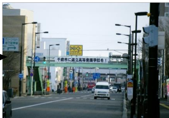
平成20（2008）年 電線類の地中化工事完了後・歩道橋撤去前
