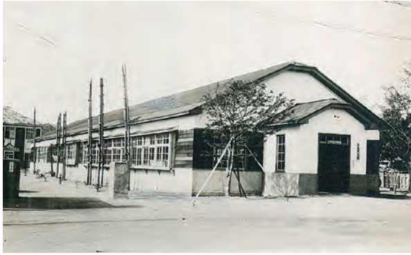
昭和22年建設 町役場庁舎（現・千歳神社第一鳥居南側）
