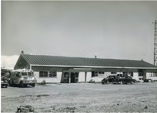
昭和26年（米空軍基地内）ターミナルビル正面
