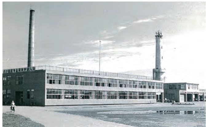
昭和33年建設 市庁舎（現・総合福祉センター位置）
