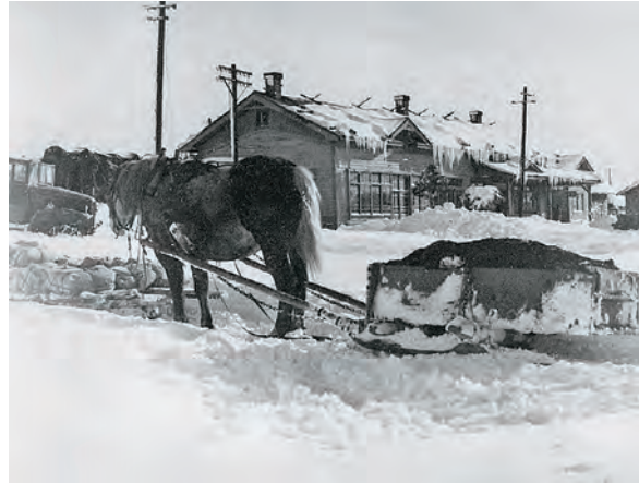
2代駅舎（昭和20年冬撮影 ASA チトセ協会提供） 昭和21年に左側半分ほどを RTO 用に改造した
