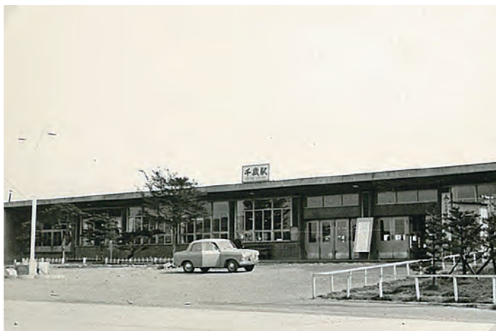
昭和29年4月1日供用の4代 駅舎、跨線橋ができる (昭和30年代後期撮影)
