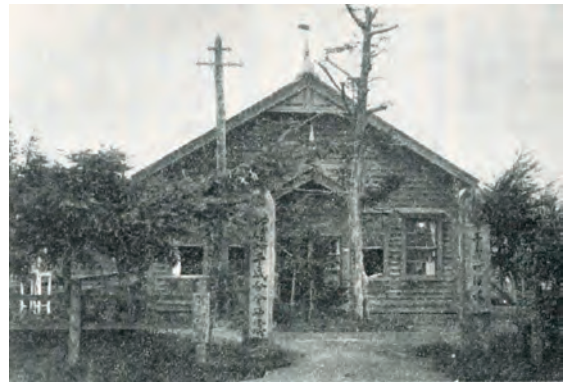
明治42年建設 村役場庁舎（現・千歳神社第一鳥居北側）
