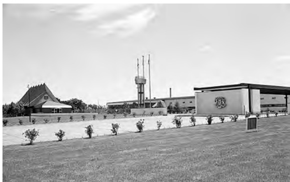
写真2-7 竣工間もないサントリー千歳プラント(左手がPRケラー)
