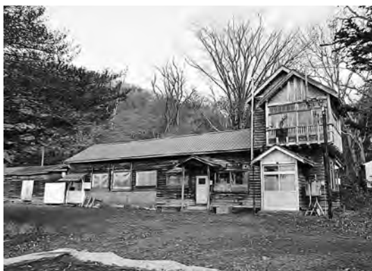
写真1-21 旧支笏湖ヒメマスふ化場 (H26.6解体)
