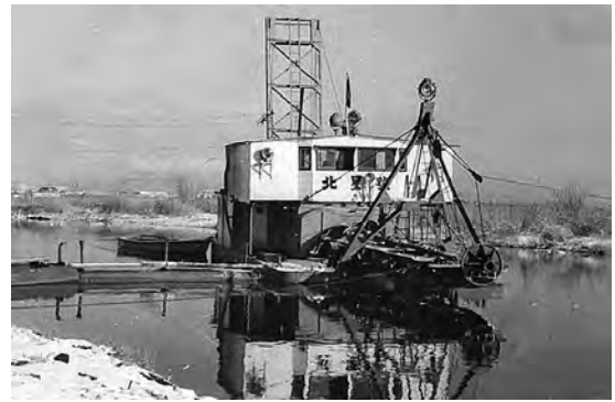
写真1-15 浚渫船「北星号」
