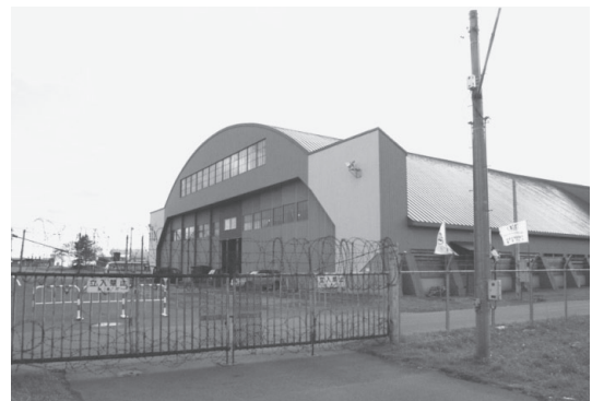
写真6-6 現存する旧航空廠施設
