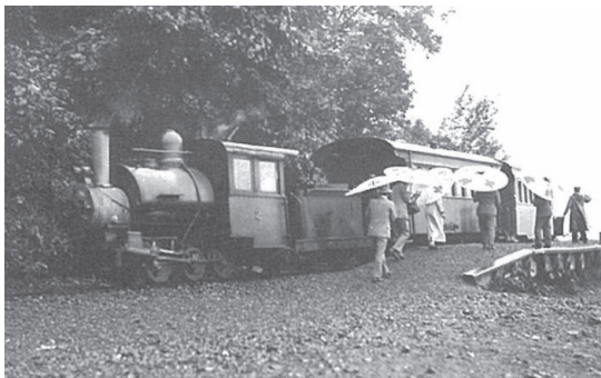
写真4-3 モラップ側の湖畔駅に停車中の山線2号機関車(王子製紙(株)苦小牧工場提供)
