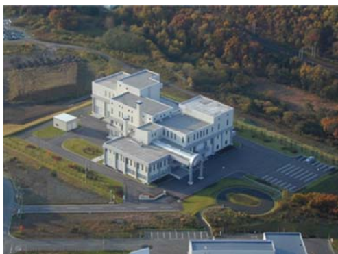
スラッジセンター
