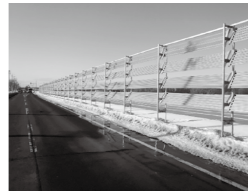
防雪柵整備 (南 26 号)
