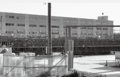
公営住宅建替事業(みどり団地) (3,792万円) 「社会資本整備総合交付金」活用
