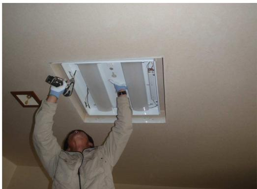
新設LED照明61台設置工事
