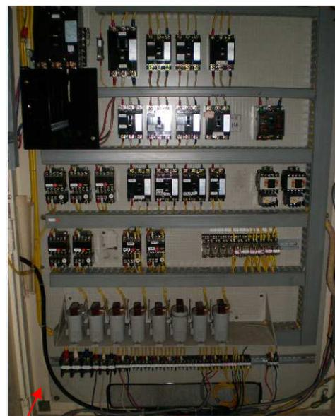
既存制御盤1および2(内部)配線、レイアウト変更。
