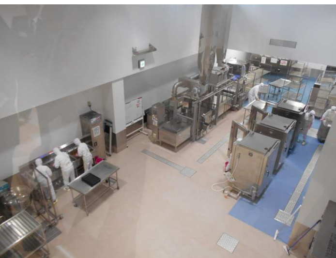
見学通路から見た焼物・揚物・蒸物調理室の様子
