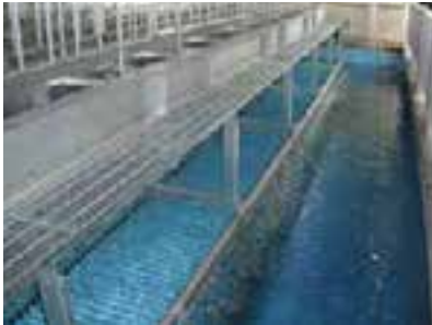
蘭越浄水場(沈澱池) Rankoshi water treatment facility (sediment pond) / 랑쥬浄水场 (沉泥池) 란코시 정수장(침전지) / โรงงานผลิตน้ำประปารันเคชิ (ป๊อตกตะลอกัน)
