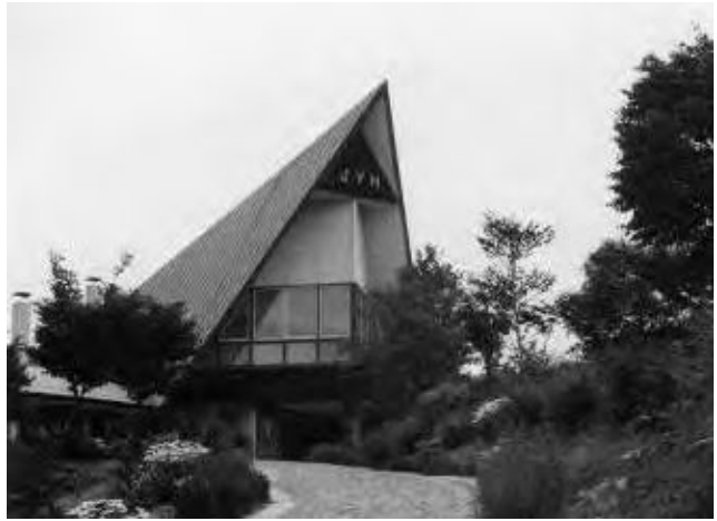
写真-9 北湯沢ユースホステル（平成7年解体・北海道ユースホステル協会提供）
