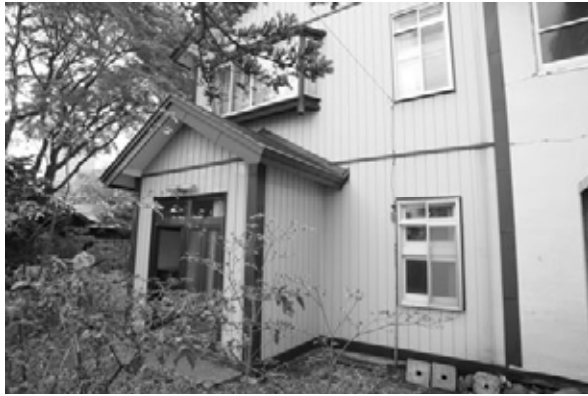
写真-2 現在の渡部家本宅
