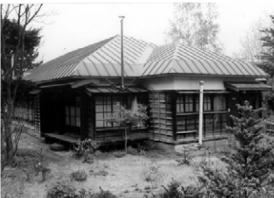
写真一10 旧美幌町長公宅（海軍甲号官舎）
