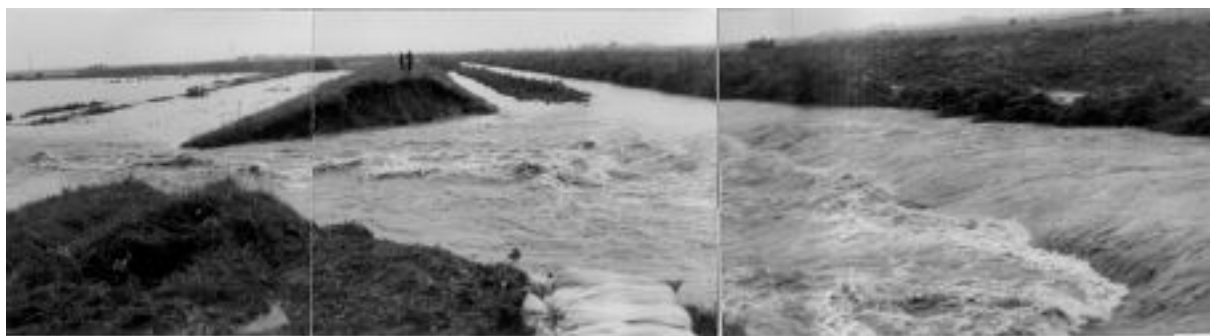
写真－1 嶮淵川左岸堤防決壊箇所
