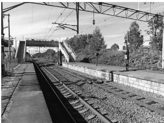
写真3 秘境駅「美々」（平成27年9月撮影） 乗降客がないため歩道橋のような珍しい簡易な跨線橋が設置されている プラットホームにも屋根がない
