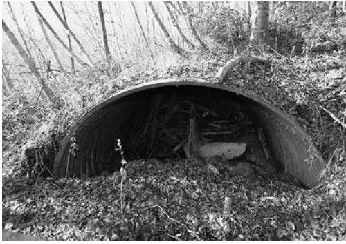
写真8 投げ込まれた廃材が残るトンネルの上部
