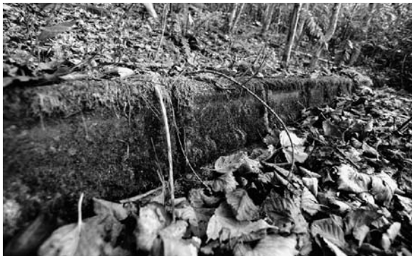
写真3 斜面に設けられた土留め用コンクリートブロック擁壁 (標高400m付近)
