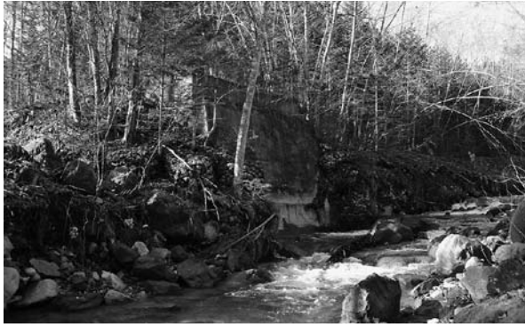
写真2 オコタンペ川に残る会場入口橋の橋台
