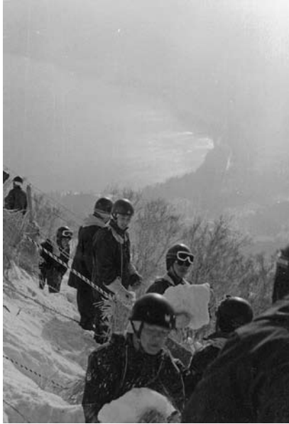
写真4 コースを造成する支援隊員 急斜面で飛雪を溜める雪柵用の ブロックを運ぶ(1971年12月撮影)
