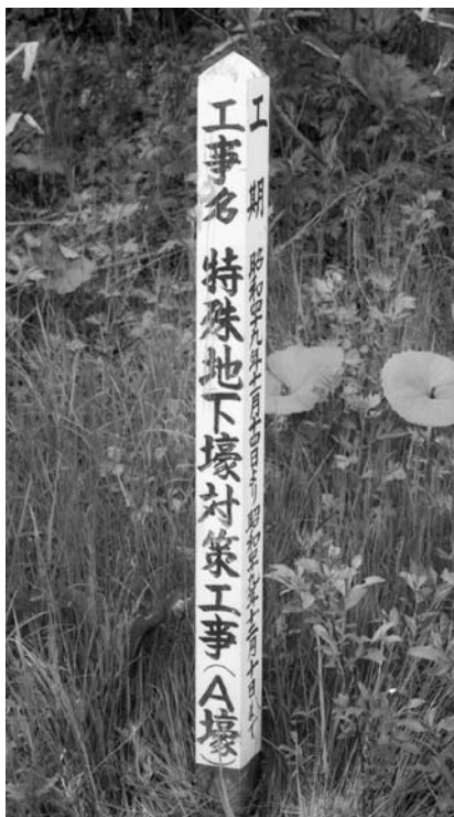
写真3 特殊地下壕対策工事竣功杭 (昭和51年7月・守屋憲治撮影) A壕は杭側面の工期から蘭2・酸素発生工場とわかる
