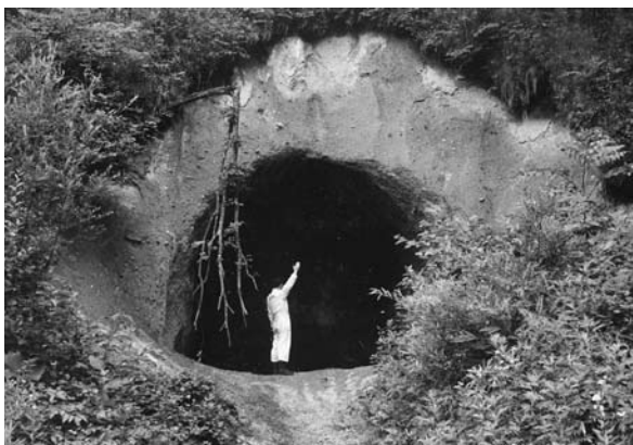
写真1 昭和35年頃の蘭越地下工場群の坑口 内部は土砂を押し入れ簡易閉塞されている 写真か ら場所を特定することはできない
