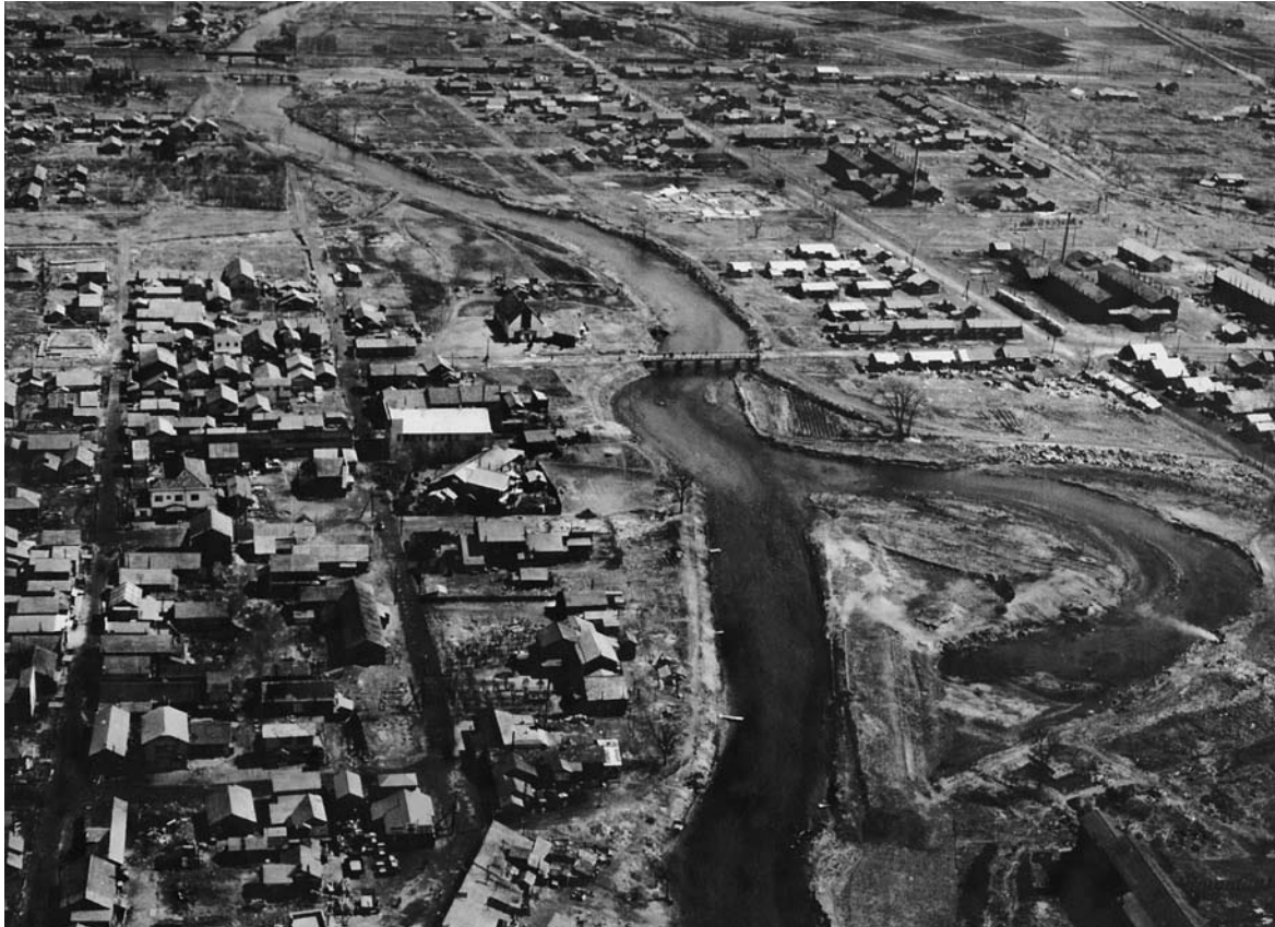
朝鮮動乱時の東雲町と清水町の空撮（昭和28年春撮影） 中央に仲の橋（S23建）とその左に千歳栄光教会会堂（S26建・H13改築）が見える 千歳川左岸（清水町）の栈橋状のものはパンパンの洗濯場 写真上部の黒い大きな建物（航空廠第一寮（男子寮）＝第二清和寮／現・消防総合庁舎）の向かいの空き地に昭和28年千歳地区警察署（現・公共職業安定所）が、古川はその後埋め立てられ旧・市庁舎（現・総合福祉センター）が33年に、51年にはその右上部に現・市庁舎が建設された
