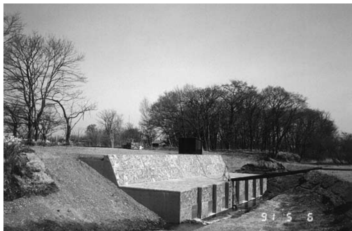
写真2 完成間近の千歳川水中観察室 支笏湖落口から約30km、石狩川河口から約70kmの地点
