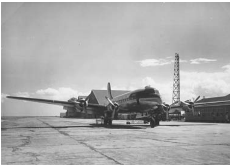
写真4 民航ターミナルビル前に駐機するDC-4「てんおう星」 格納庫上に管制塔が見える （昭和27年 米空軍千歳基地）
