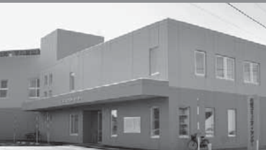
花園コミセンの建設 (3億7,970万円) (防衛省「民生安定施設 設置助成事業」活用)
