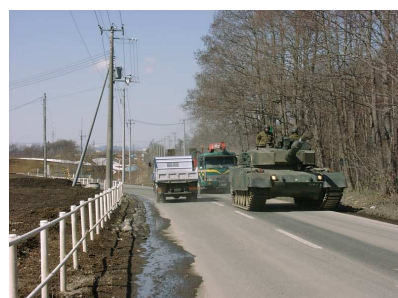
<拡幅工事前の通行状態>
