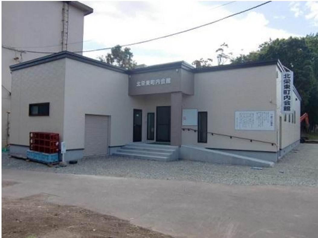
【町内会館整備（北栄東町内会館新築）】
