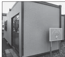
桜木町内会が購入した備品用倉庫
