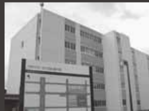
市営住宅(いずみ・みどり団地)の建替 (5億7,681万円)
