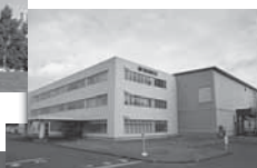
半導体製造工場
