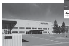
半導体製造工場
