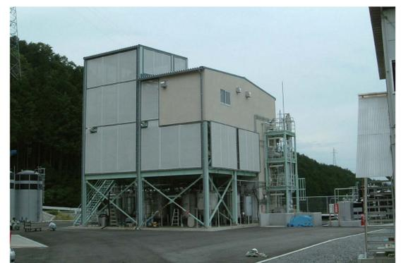
国内有数の林産資源生産地であり、市内に約30の製材所が集中する岡山県真庭地区では、製材端材や林地残材などを主原料に、遺伝子組み換え酵母を使い、約250kg/日のエタノールを製造。精製したエタノールは三井造船が開発した技術により無水化される。
