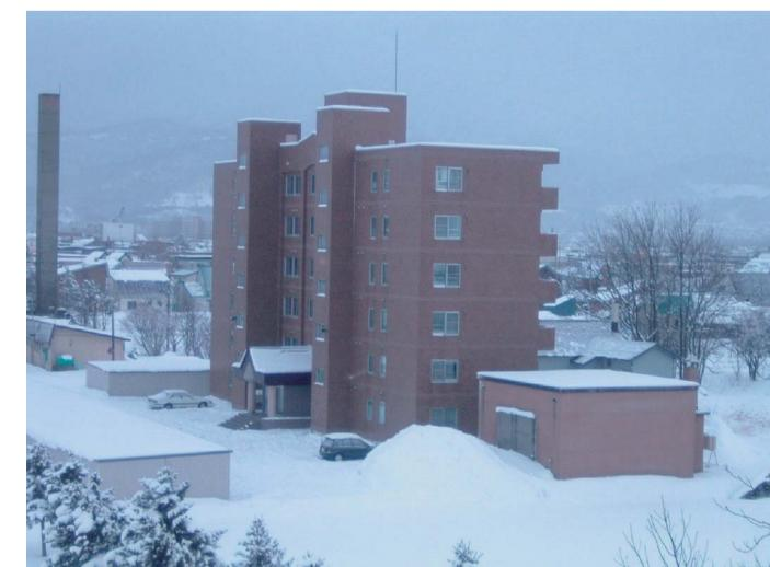
世界初の雪冷房マンションであり、 従来、主に農産物貯蔵に利用されることが多かった雪冷房が、本施 設以降、居住空間にも盛んに活用されるようになったことで知られる。 システムは、雪を強制的に溶かし、 雪解け冷水を循環させて冷房を行う冷水循環式。
