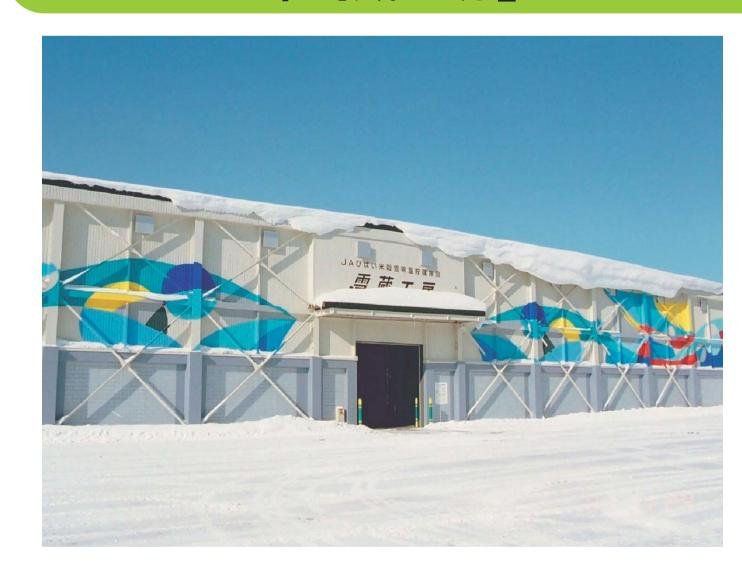
国内最大となる3,600tの貯雪量を誇る玄米貯蔵施設。全空気式雪冷房により庫内を温度5℃、湿度70%の低温環境とし、常に新米の食味を提供している。運転停止や温度調整も可能で、消費電力は従来に比べ1/2以下となっている。
