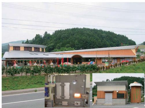
2002年四月に開園。木造平屋の園舎の床暖房施設として、公立保育園としては全国で初めて国産ペレットボイラーを導入。床面積769.61m<sup>2</sup>のうち9割にあたる681.57m<sup>2</sup>を温水循環床暖房にしている。ペレットボイラーの灰出しは2週間に1回。灰は融雪材、土壌改良剤として使用している。
