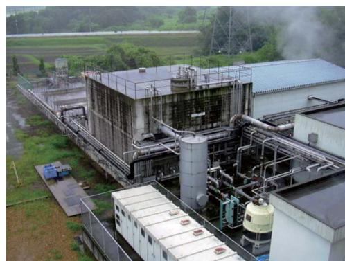
豆腐、油揚げ、いなり寿司等の各種加工米飯を製造している同社工場では、油揚げ製造廃液が濃厚廃液で、排水処理への汚濁負荷が高かったが、この高濃度廃液をメタン発酵し燃料とすることで、排水処理容積や電気量を抑えることが可能となった。
