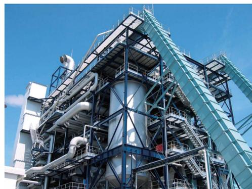
日本製紙 勿来工場では、建築廃材由来の木材チップを主燃料にした内部循環流動床ボイラーを採用。重油から燃料転換したことで年間約34,000kl消費されていた重油の約98%が削減され、これに伴い年間約10万tの二酸化炭素の削減が見込まれる。
