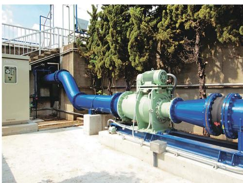
東京都下水道局森ヶ崎水再生センターでは、処理された水を放流する際のわずかな落差を活用した小水力発電を2005年6月より開始している。発電設備の発電出力は東・西処理施設合わせて約100kW。
