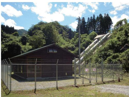
清和発電所は、熊本県上益城郡山都町(旧清和村)が緑川の豊かな水資源を活かし、既設の砂防えん堤を利用して開発したもの。年間可能発電電力量は952MWhとなっている。
