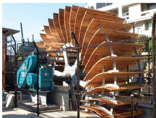
山梨県都留市の市庁舎前に設置された家中川小水力市民発電所(愛称:元気くん1号)は、市役所隣の小学校校庭との落差わずか2mを利用した、掛け水車方式の小水力発電所。
