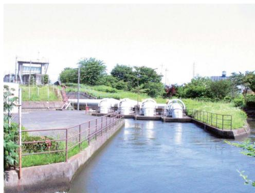
群馬県吉岡町を流れる天狗岩用水路(農業用)の落差7.36m延長約100m区間を利用して発電を行っている発電所。農業用水路の流れをそのまま利用して発電を行う流れ込み式。
