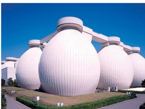
下水処理過程で発生する汚泥処理を行う横浜市環境創造局北部汚泥資源化センターでは、処理過程で発生する消化ガスを燃料にして、ガスエンジンで電気を発電。所内電力の約70%を賄っているほか、エンジンから発生する熱も消化タンクの加熱等に利用している。
