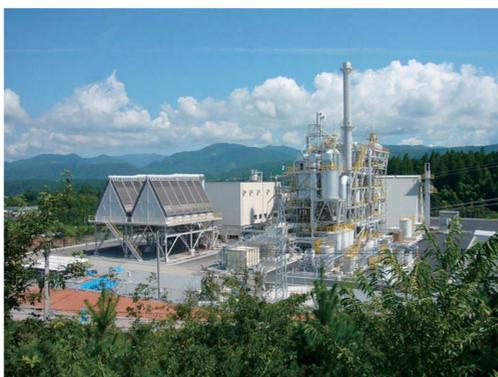
国内有数の木材生産地である大分県日田市に立地する木質バイオマス発電所。建築発生木材に由来する木質チップを購入し、発電した電気を電気事業者に供給している。同地域で大量発生する樹皮(バーク)についても、ボイラ用燃料として受け入れを開始している。
