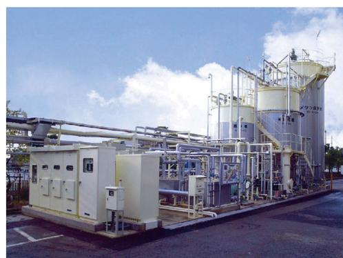
生活協同組合コープこうべ直営の食品工場で生産する豆腐、麺、パンなどの製造過程で発電する生ゴミ5tと排水処理施設から排出される汚泥1tをメタンガスに変換し、電気や熱エネルギーとして工場内で再利用している。
