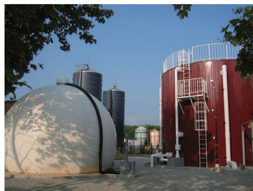
くずまき高原牧場内の牛の排泄物を発酵させてメタンガスを抽出し、発電ならびに熱回収を行うシステム。畜ふんの適性管理を主な目的として導入したもので、発生電力および熱はプラント内の負荷で消費している。
