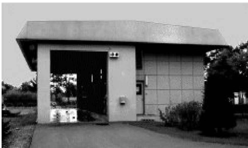
写真 2 - 1 汚水投入施設
