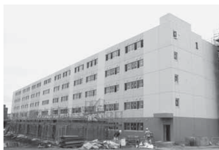
壁式RC構造が採用されたみどり団地の建設工事
