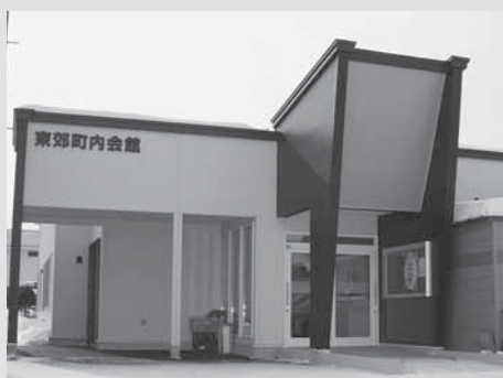
再編交付金を活用して建てられた東郊町内会館。入り口の段差をなくすなど、誰にもやさしい建物になっています。
