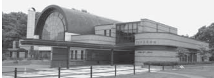
工事中は館内の一部が利用できません
