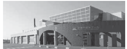
さまざまな講習会を行う温水プール
